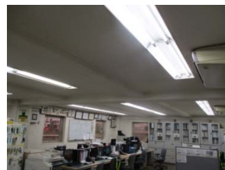
羽田 支社事務所照明LED化
